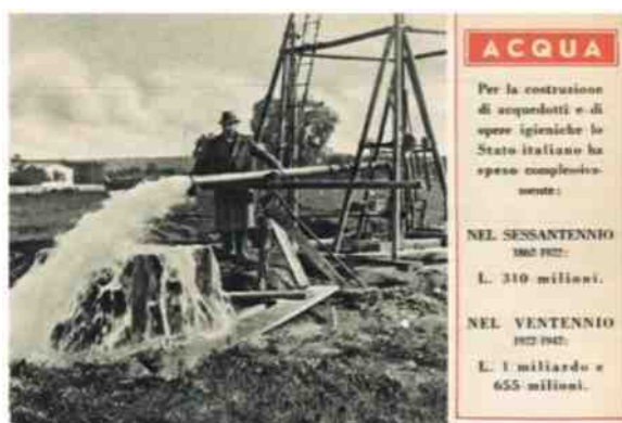
Pompinstallaties en drainagesystemen werden aangelegd.
